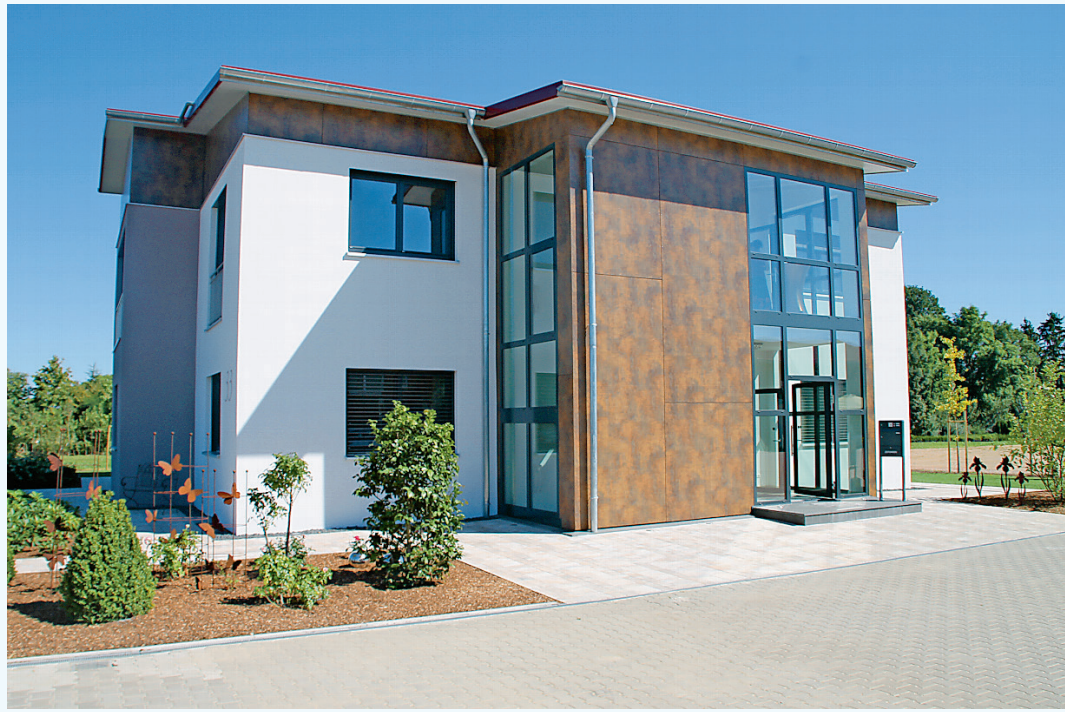
In der Schützenstraße 33 hat die Firma Sailer Baumschulen ein neues Bürogebäude errichtet.
